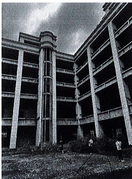
（图四：项目中庭内景）
