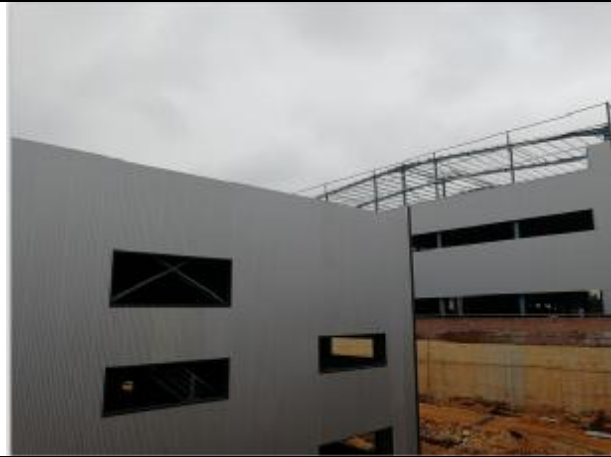
项目南侧-在建厂房
